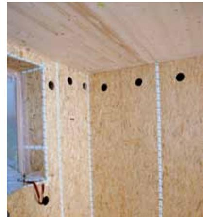
Holzriegelwände werden je nach Vorfertigungsgrad bereits im Werk mit der Zellulosedämmung befüllt oder auch vor Ort.
