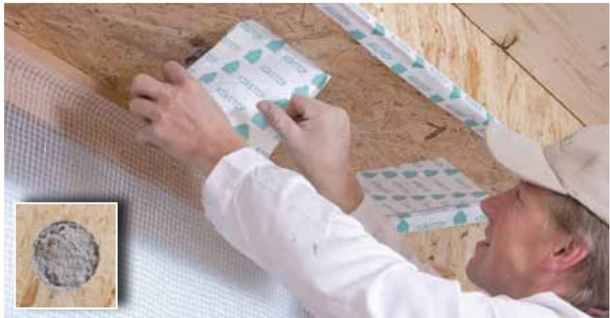
Die Zellulosefasern verfilzen sich im Bauteil zu einer kompakten passgenauen Dämm-Matte. Sind die Hohlräume vollständig gefüllt, werden die Einblaslöcher mit den Airstop Dichtpflastern luftdicht verschlossen.
