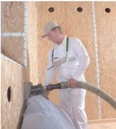
Mit Druck wird die Zellulose in die Hohlräume eingebracht - fugenlos und verschnittfrei. Der Fachmann arbeitet hier mit speziellen Einblasdüsen, die ihm ein rasches und sauberes Arbeiten ermöglichen.
