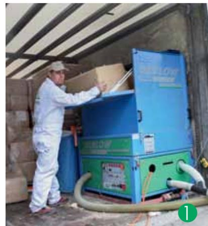
Der Einblas-Fachmann kommt mit seinem LKW auf die Baustelle und bringt alles mit, was er braucht: Die Einblasmaschine und das in Säcken abgepackte **WOODYCELL**.
