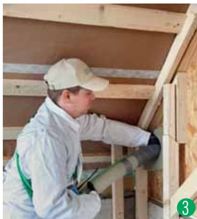
Der Fachmann steuert im Gebäude mittels Funk die Maschine und befüllt in kürzester Zeit die vorbereiteten Gefache.
