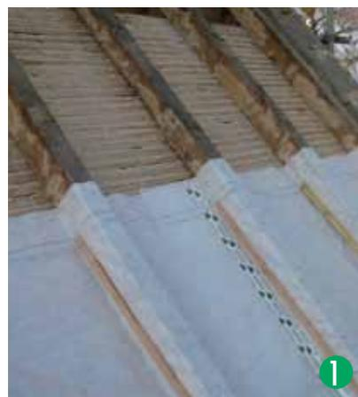
Die alte Dachhaut wird entfernt. Die Dampfbremse (z.B. FH Vliesdampfbremse transparent) wird im sogenannten Sub-top-Verfahren über die Sparren verlegt und seitlich mit Latten oder Anpress-Streifen fixiert. Die luftdichte Abdichtung erfolgt mit dem AIRSTOP Klebesystem.
