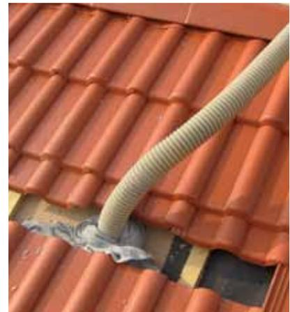
Bei bereits gedeckten Dächern müssen nur wenige Ziegel ausgehängt werden, um Platz für die Dämmarbeiten zu schaffen.
