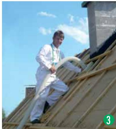
Nach Fertigstellung des Unterdaches wird mittels Einblastechnik die Zellulosedämmung eingebracht. Im Gefach verfilzen sich die Fasern zu einer kompakten, fugenlosen Dämm-Matte.
