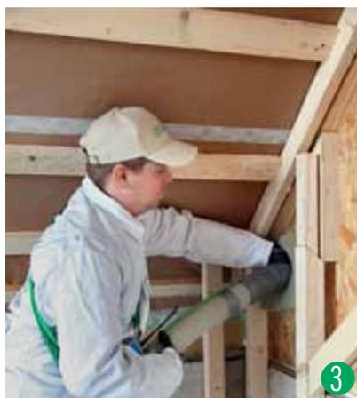
L'insufflateur contrôle la machine par une radio-commande dans le bâtiment et remplit les volumes préalablement préparés en un rien de temps.
