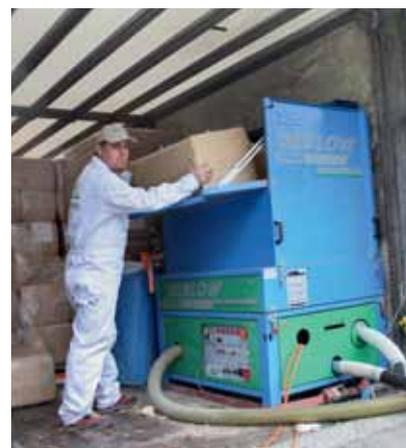
Le spécialiste en insufflation se rend sur le chantier avec son camion et amène tout ce dont il a besoin: la machine à insuffler et le matériau WOODYCELL comprimé dans des sacs.
