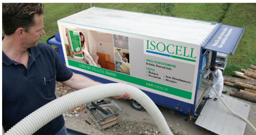
Il ne reste que le tuyau d'insufflation à amener à l'intérieur, sans avoir à monter une quantité énorme de matériel jusqu'au lieu de travail.
