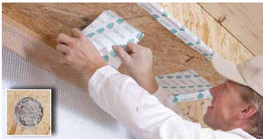
Les fibres de cellulose se feutrent dans la paroi pour former un matelas isolant compact et dimensionné avec précision. Lorsque les cavités sont complètement remplies, les orifices d'insufflation seront fermés de façon étanche au moyen de patches d'étanchéité AIRSTOP.
