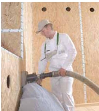
La cellulose est amenée sous pression dans les cavités à isoler – sans joints et sans découpes. Le spécialiste utilise ici des buses d'injection spécifiques qui lui permettent un travail rapide et propre.
