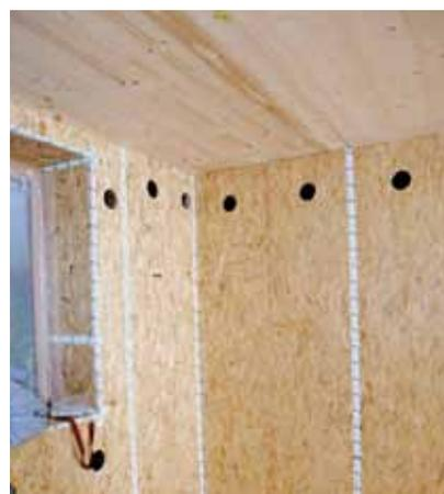
Selon leur degré de préfabrication, les parois en ossature bois sont soit remplies d'isolant cellulosique déjà en usine, soit sur chantier.
