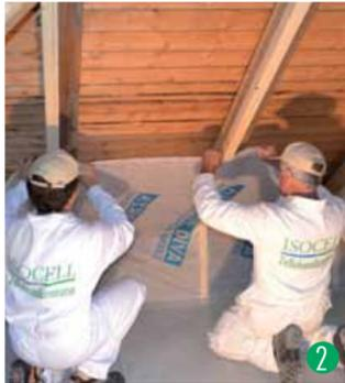
L'écran frein-vapeur est posé avec un chevauchement des lats et fixé mécaniquement au moyen d'agrafes.
