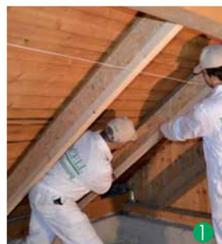
Selon l'épaisseur d'isolant souhaitée, les chevrons doivent être renforcés (doublés) à l'intérieur des combles. Pour la construction, deux variantes sont détaillées ci-après (voir schémas).
