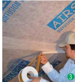
Il est très important de veiller à l'étanchéité à l'air des chevauchements collés, des raccords et des passages techniques. Voir à ce sujet la brochure « L'étanchéité à l'air dans le détail ».
